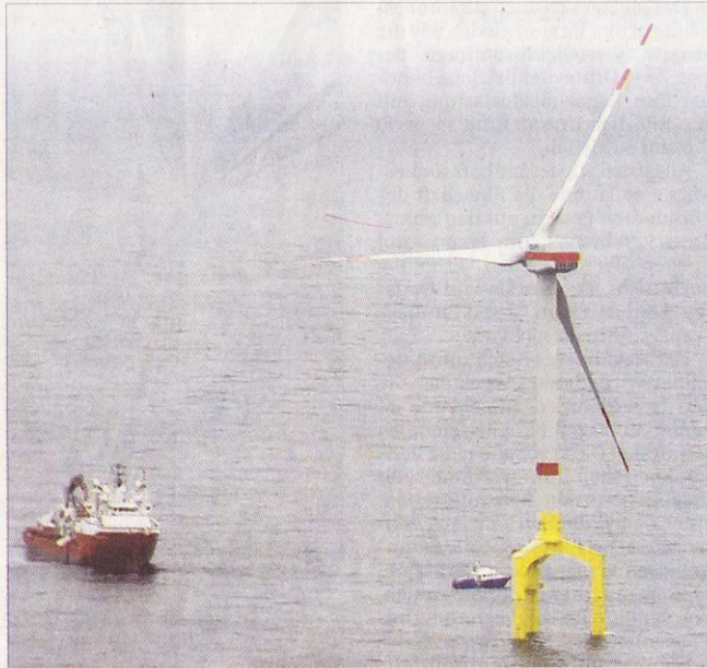
Nordwestlich der Insel Borkum entsteht der Windpark „Bard 1“.
