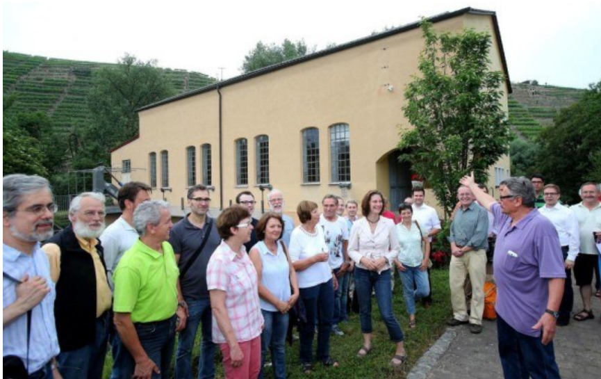
Die Rödcker'sche Mühle an der Enz liefert Strom seit dem Jahr 1901. Sie ist Teil der "Erneuerbare Energien Route" und wurde gestern besichtigt.
