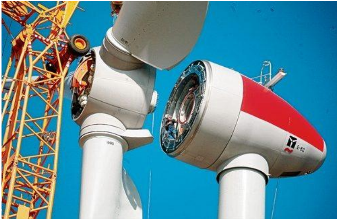
Ganz langsam hebt sich die Rotornabe mit ihren Windflügeln in 136 Meter Höhe. Bilder: Alfred Drossel
