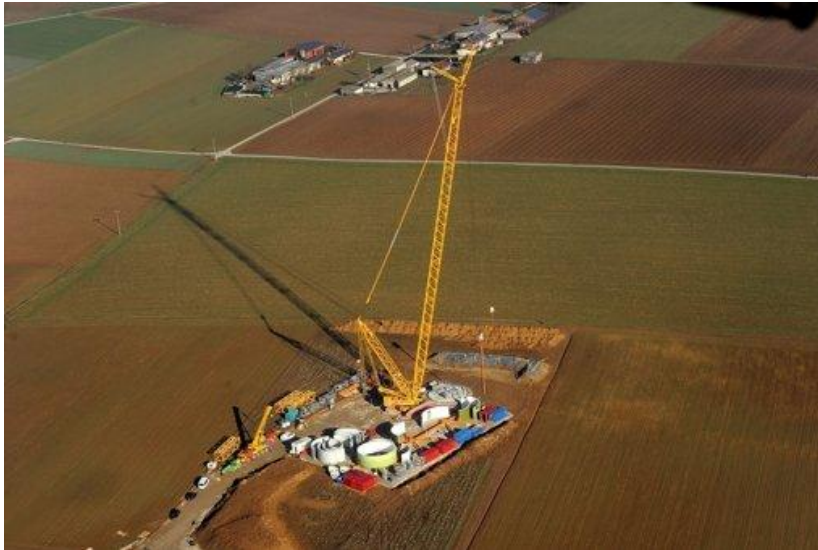
Über dem Fundament für das Windrad ragt der riesige Kran empor. Foto: Kuhnle
